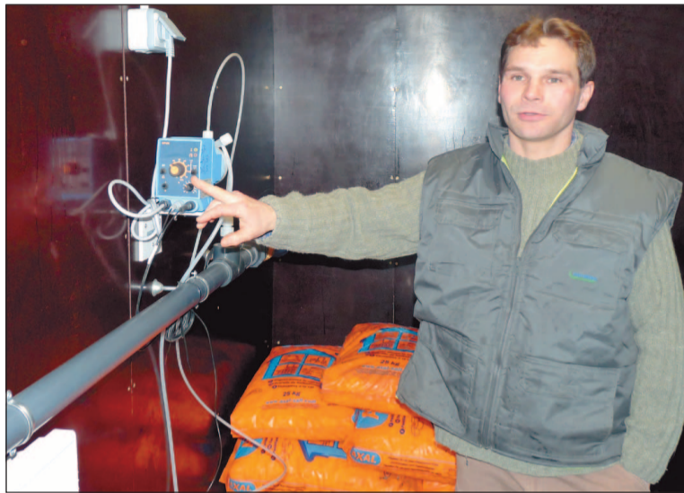
Vincent Potriquet : "il suffit de régler la pompe sur le pH souhaité pour le traitement".
